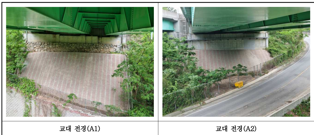
【사진 22.3.8】 교대 전경
