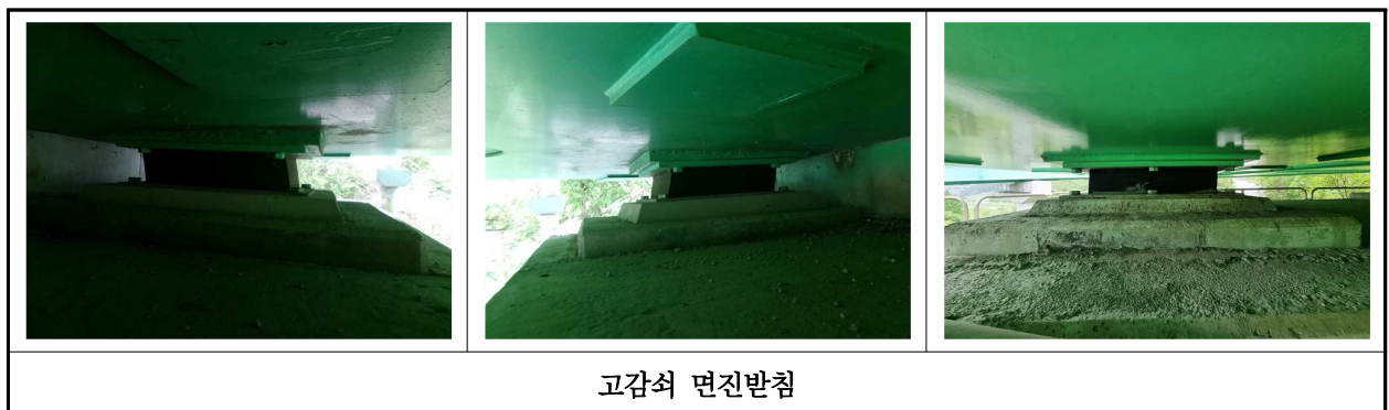
【사진 22.3.14】 교량받침 전경
