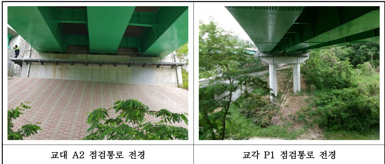
【사진 22.3.27】 교량 점검시설 전경
