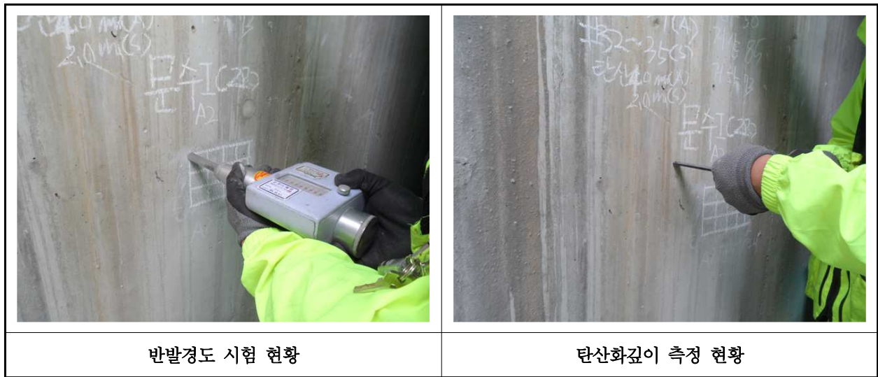
【사진 22.4.1】 콘크리트 내구성조사 현황
