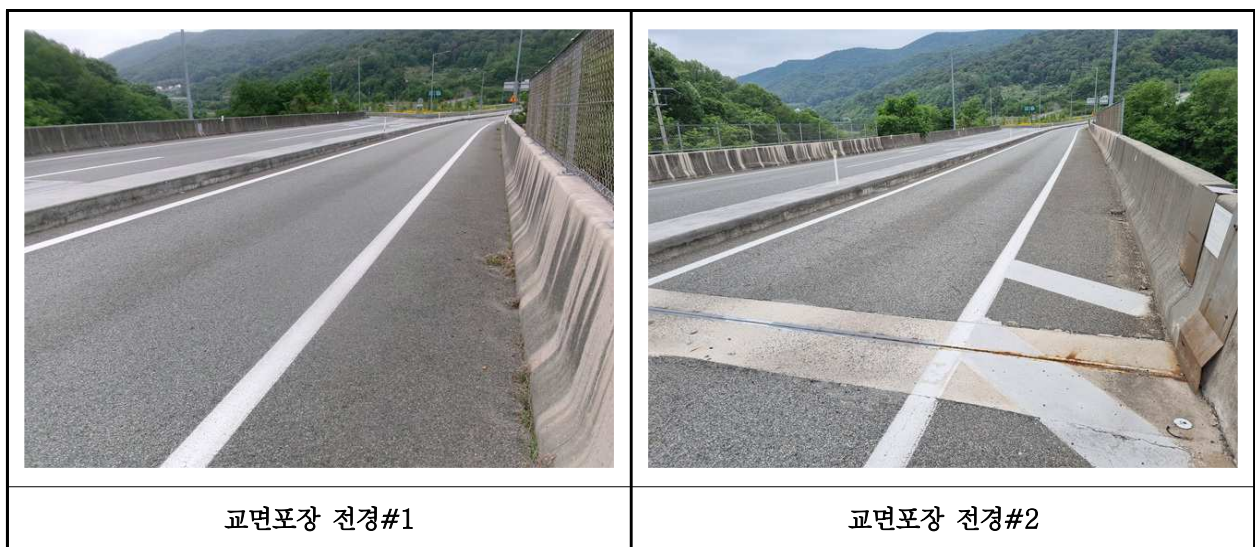
【사진 22.3.21】 교면포장 전경
