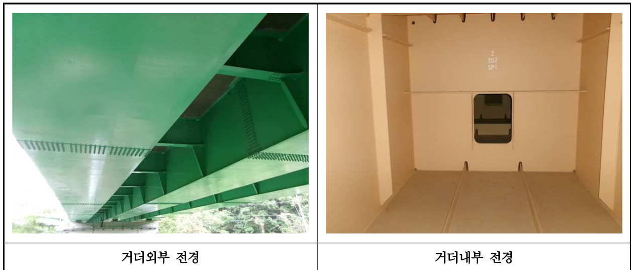
【사진 22.3.4】 거더 전경
