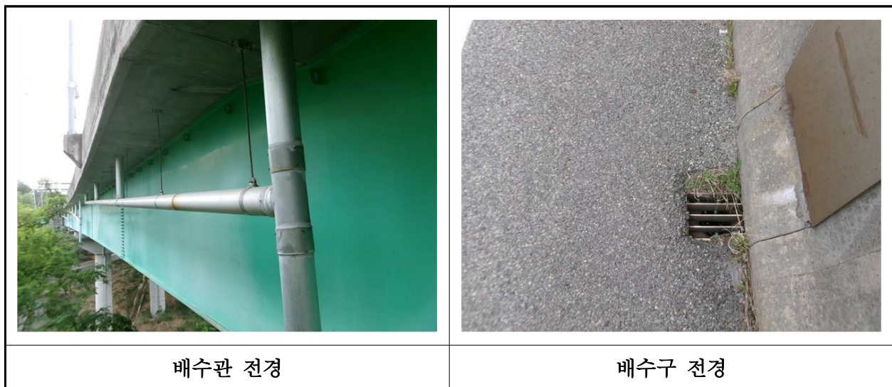
【사진 22.3.23】 배수시설 전경
